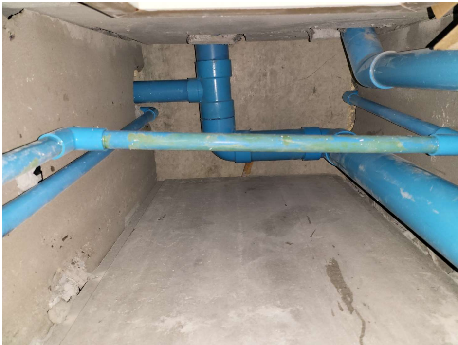
ภาพการปิดช่องเปิดระหว่างชั้น (ชาร์ปงานระบบ) ป้องกันการแพร่กระจายควันไฟ
